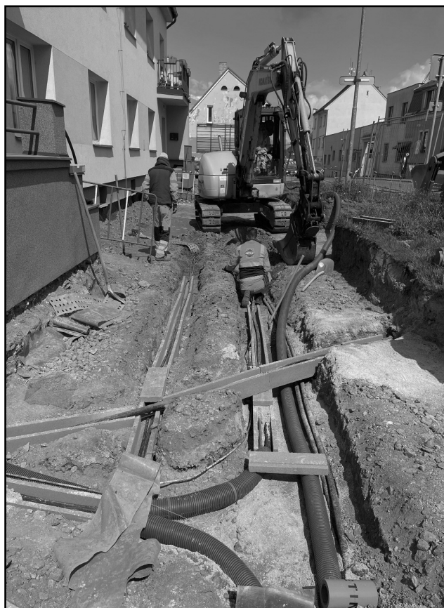
Zemní práce na přípravě pláň pro nové parkoviště v okolí obytných domů v Souhradí.
